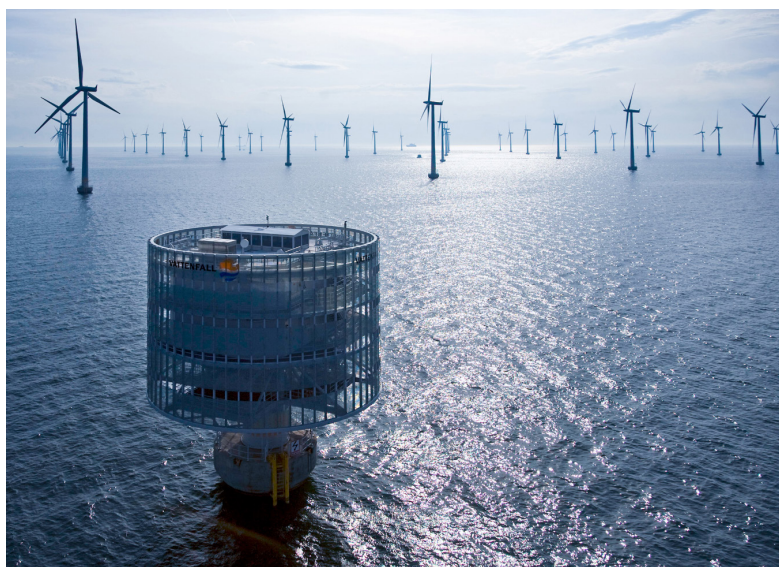
Figur 19: Storskalig vindkraftpark, Lillgrund med transformatorstation 79
